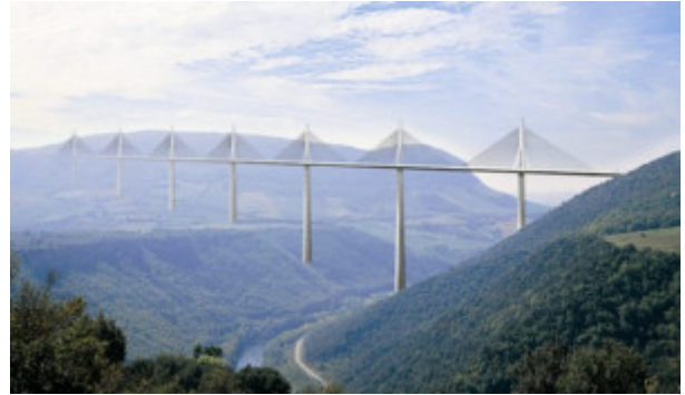
Groupe de Travail CND et Génie Civil (Confédération Française pour les Essais Non Destructifs)
